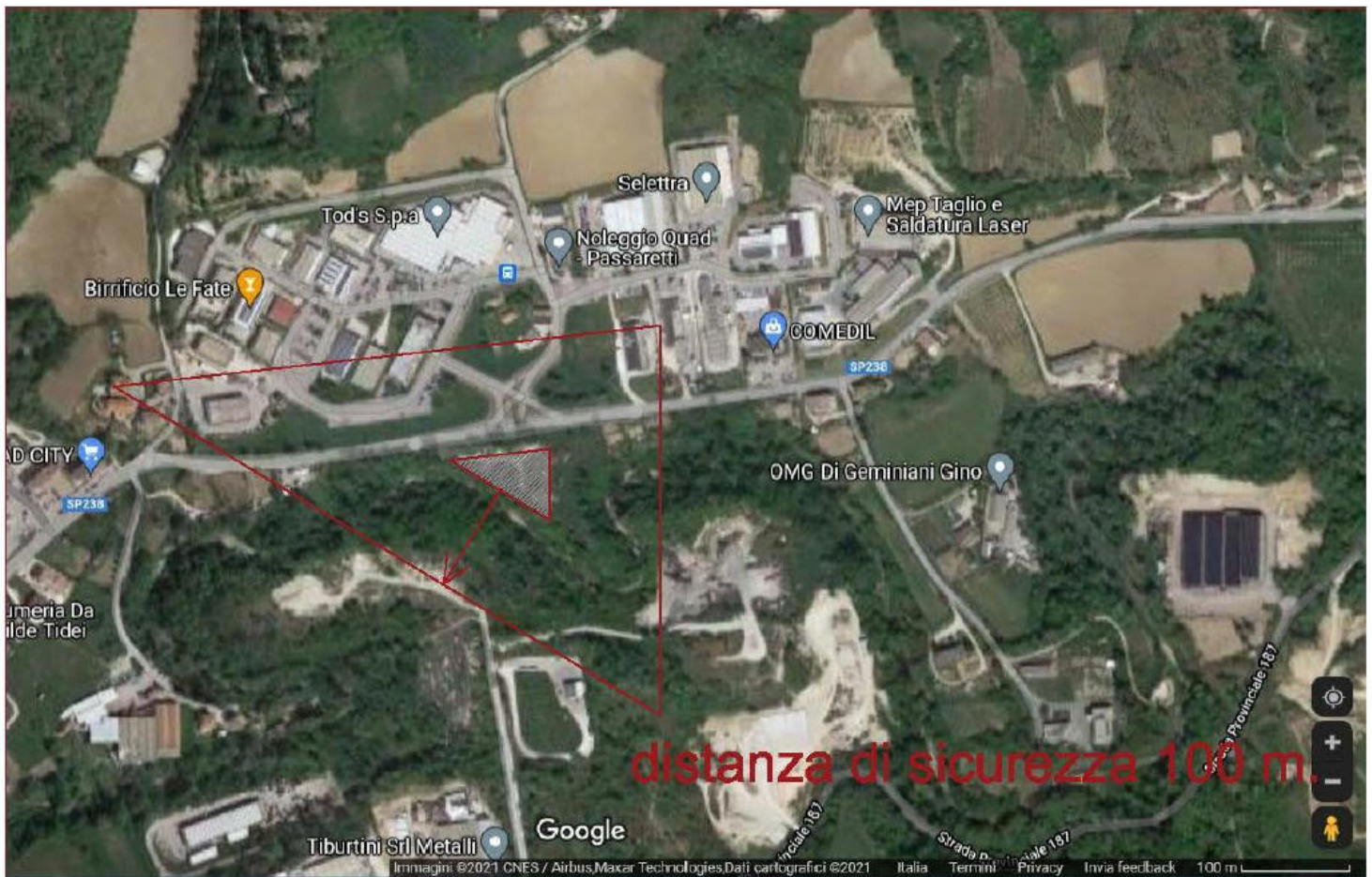
Impianto: "CIIP Cicli Integrati Primari" – via Depuratore Civile Santa Maria a Terme – Comunanza
