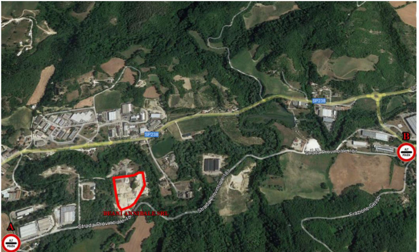
Impianto: "BEANI ANNIBALE S.R.L." – località Pianerie snc – Comunanza
