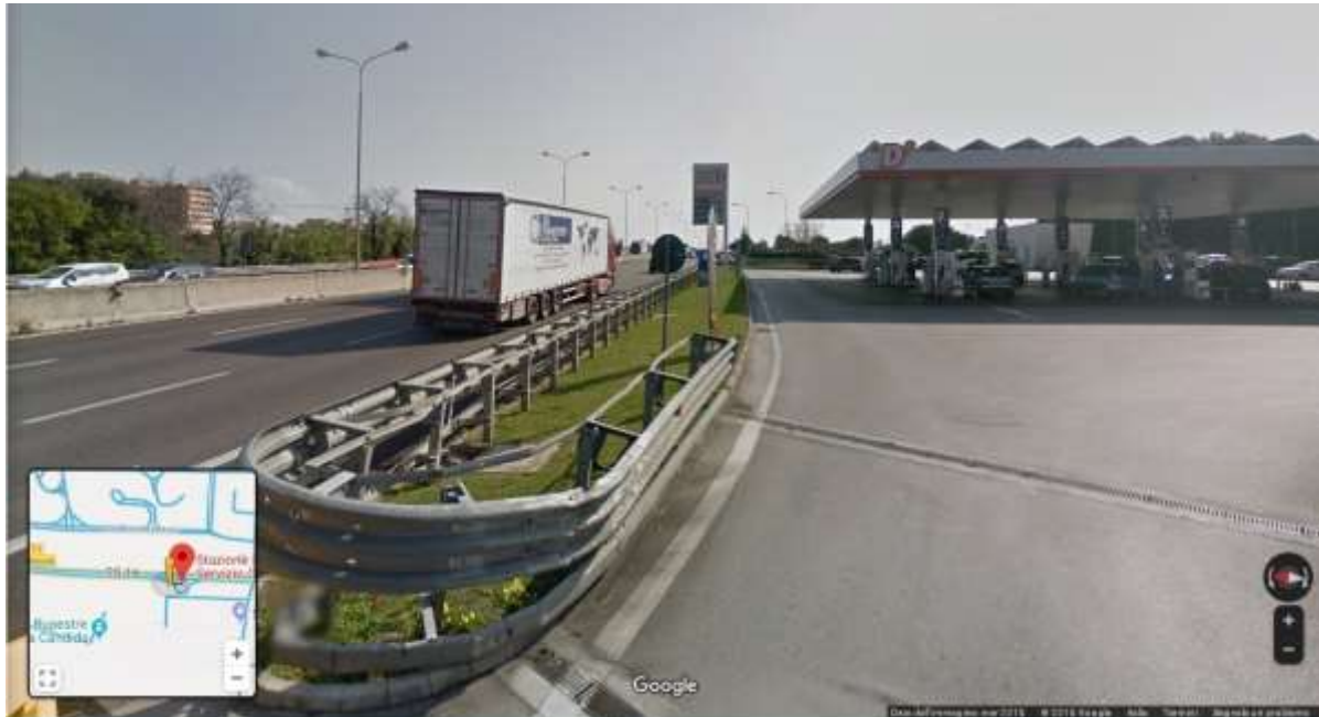
Figura 7 - Stazione di servizio di Bari - (SS 16 direzione sud)
