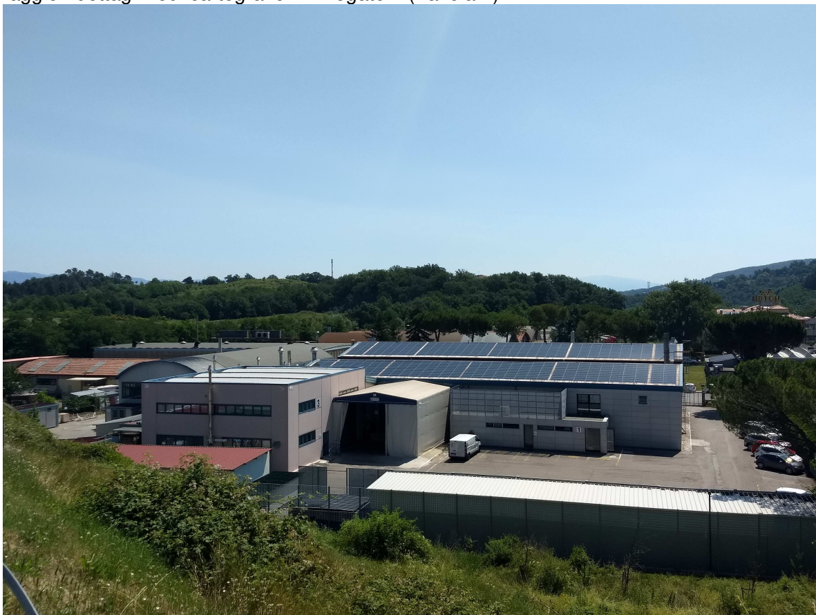
Figura 1. Vista dello stabilimento Galvair
