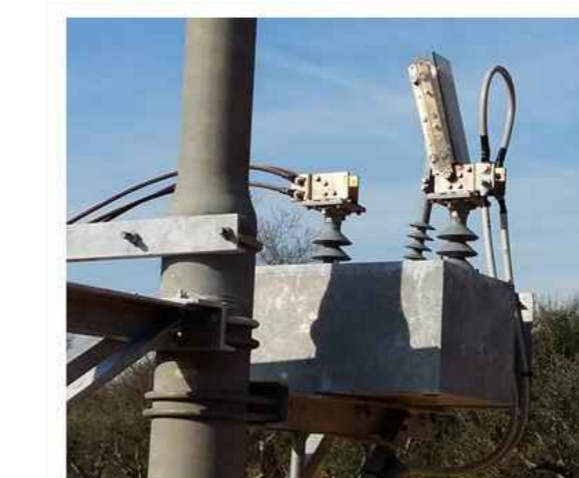
Sezionatore con lama di terra aperta
