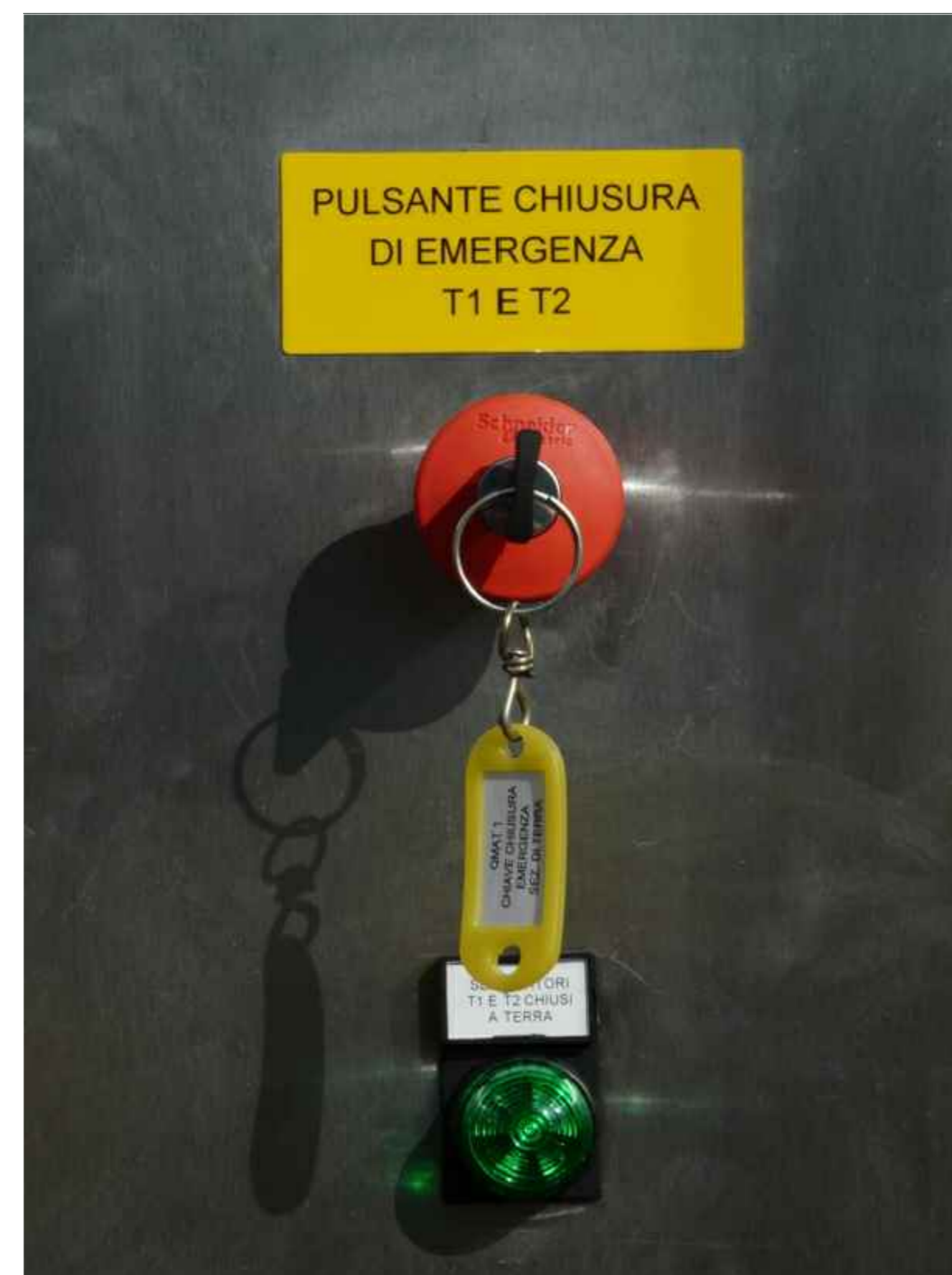
Pulsante a fungo rosso da premere, con successiva estrazione della chiave di rilascio
