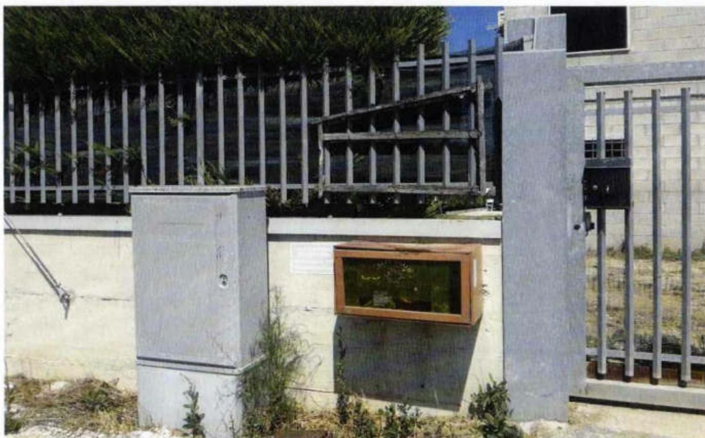
**FOTO 6- PARTICOLARE ATTACCO AUTOPOMPA VVFF**
