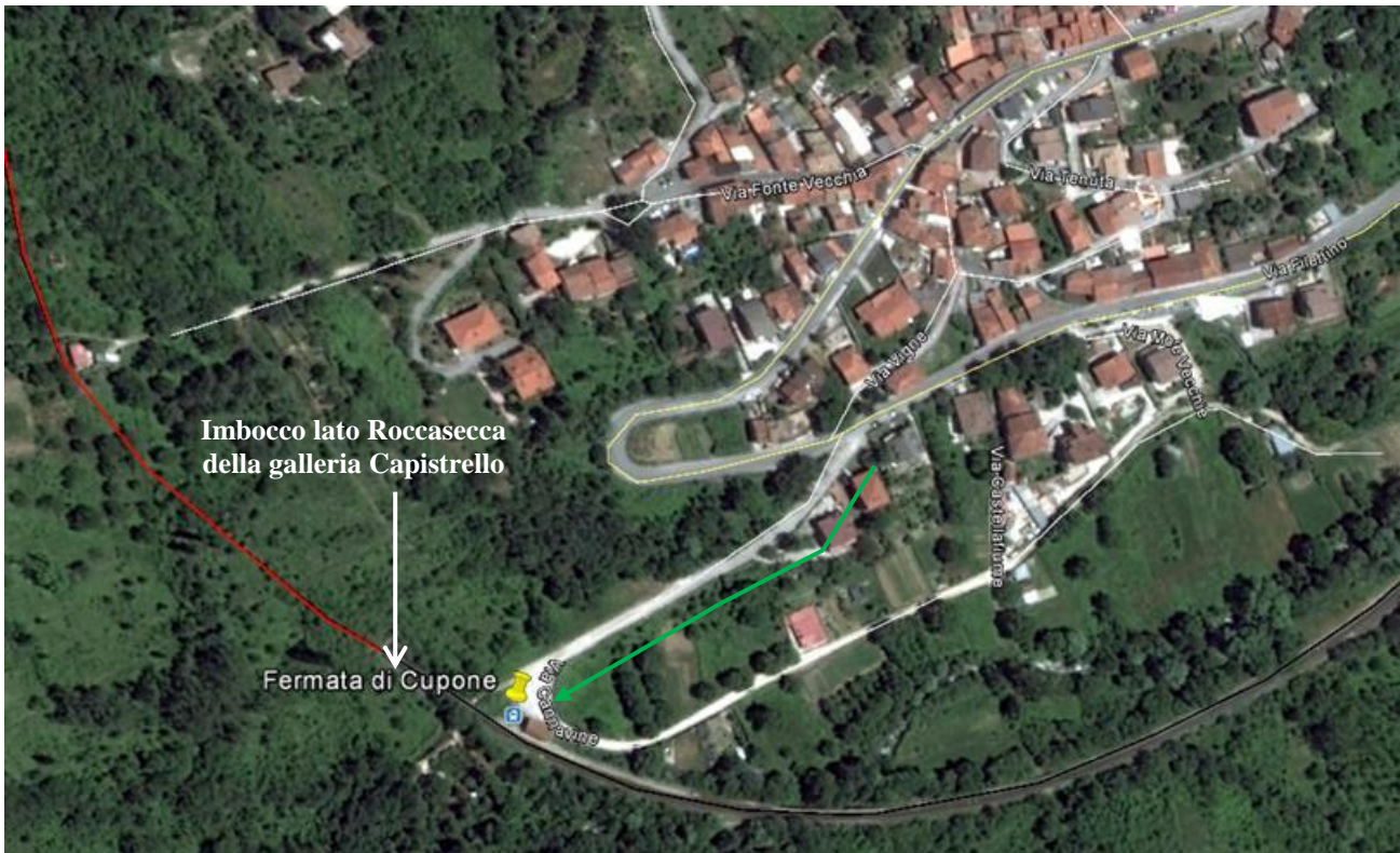
Accessibilità stradale all'imbocco lato Roccasecca (Sud) della galleria Capistrello.
