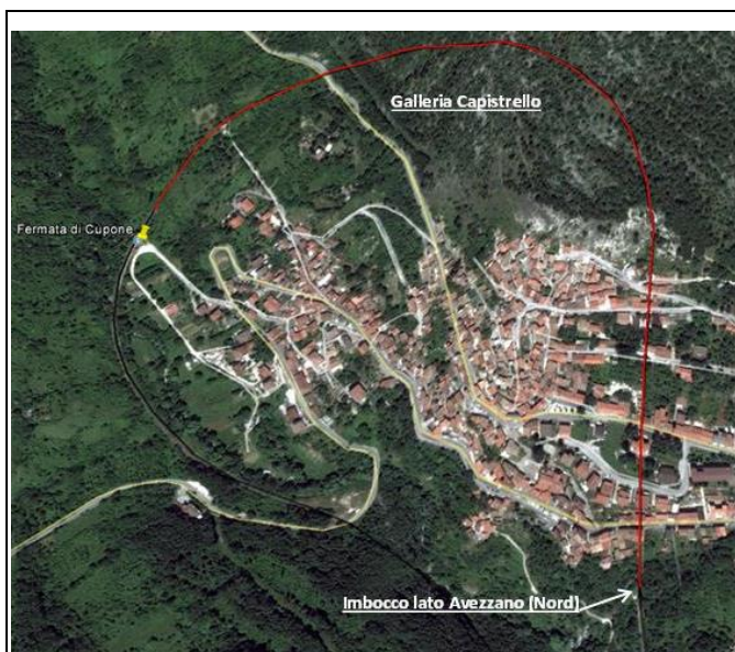
Imbocco lato Avezzano (Nord) della galleria Capistrello
