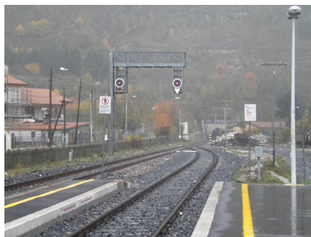
Stazione impresenziata di Capistrello e imbocco della galleria La Giorgia.
