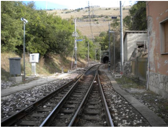
Imbocco lato Roma della galleria Pietrafitta
