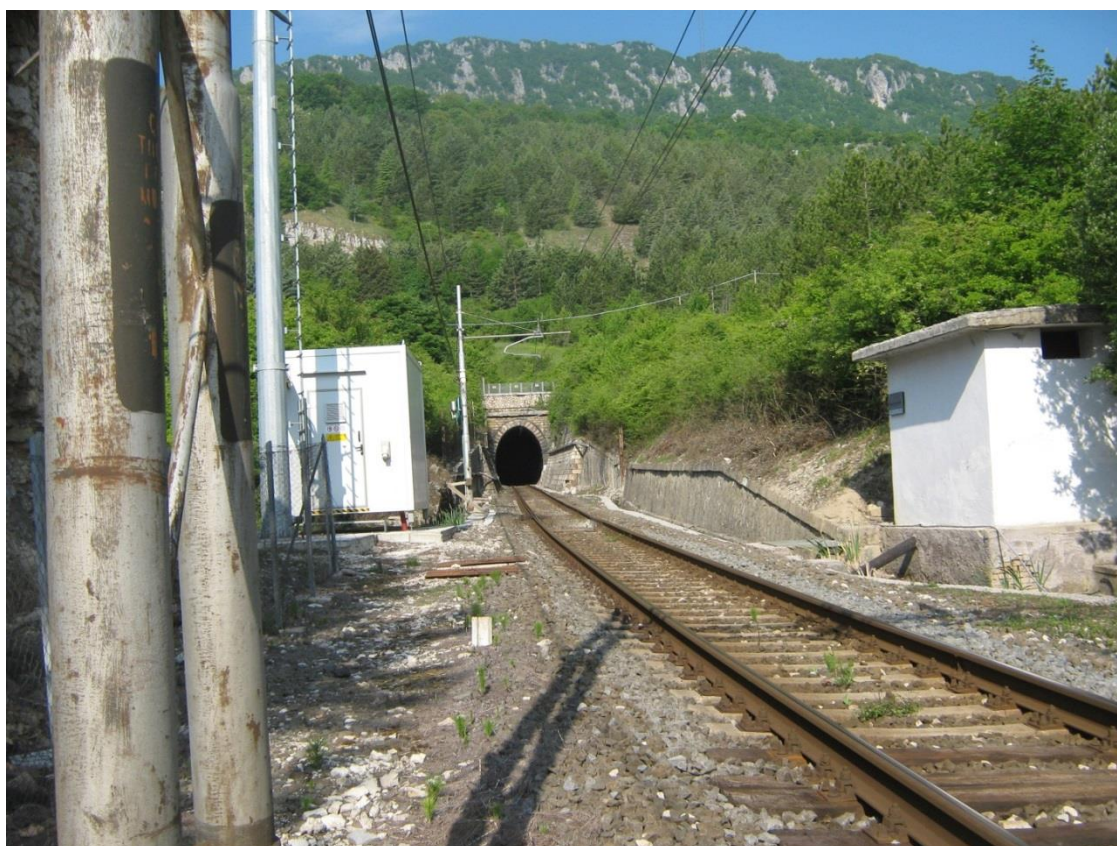
FOTOGRAFIA IMBOCCO LATO SULMONA
