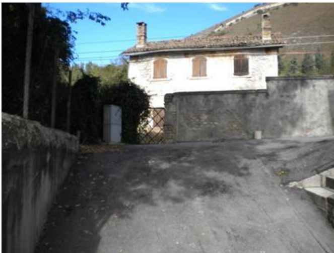
Cancello di accesso all'imbocco lato Sulmona della galleria Carrito
