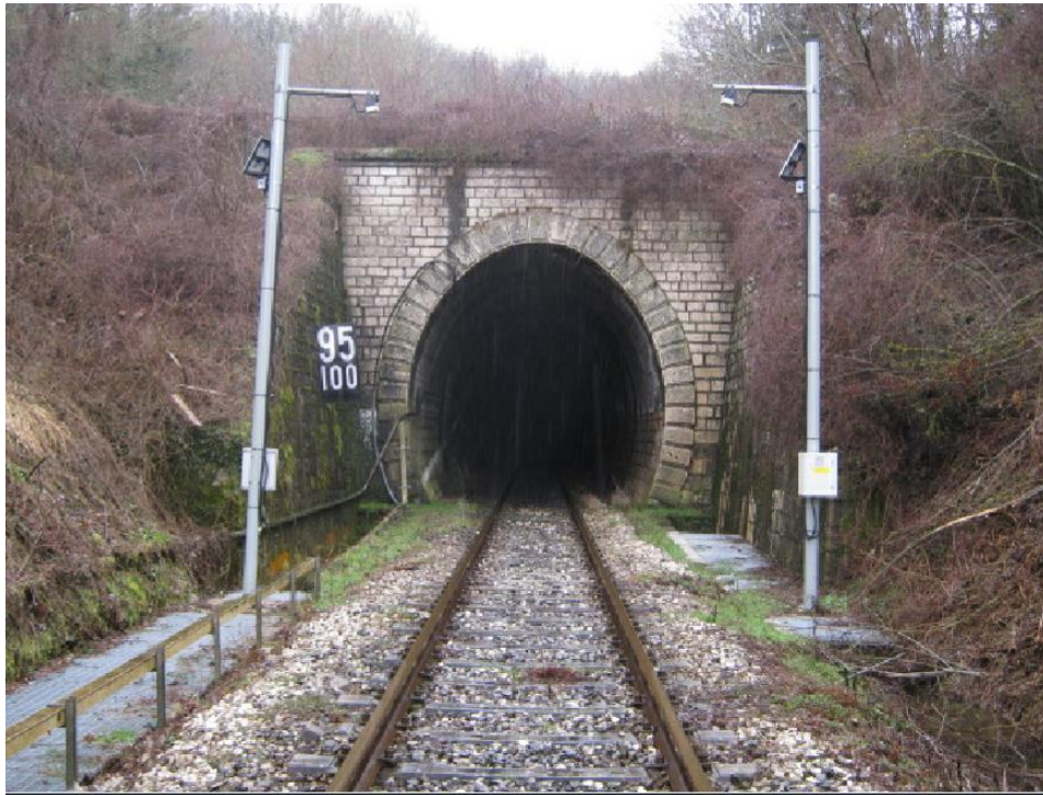
FOTOGRAFIA IMBOCCO LATO CARPINONE
