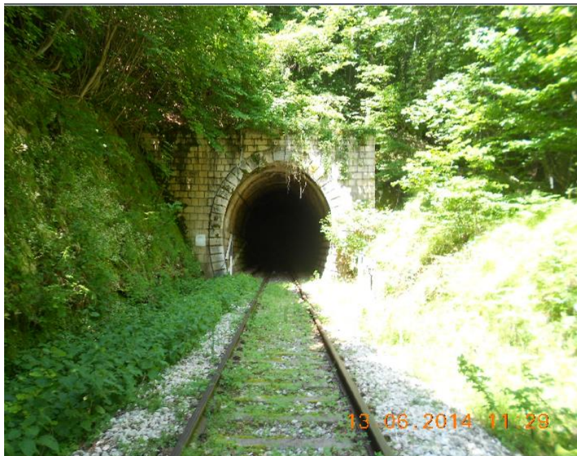
FOTOGRAFIA IMBOCCO LATO CARPINONE
