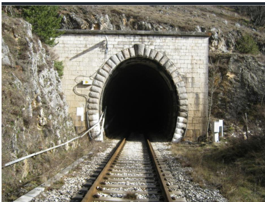
FOTOGRAFIA IMBOCCO LATO CARPINONE
