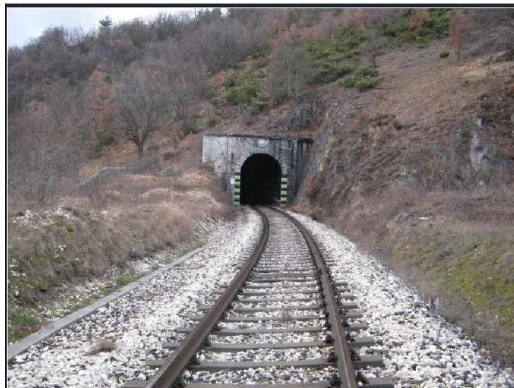
FOTO IMBOCCO LATO SULMONA
