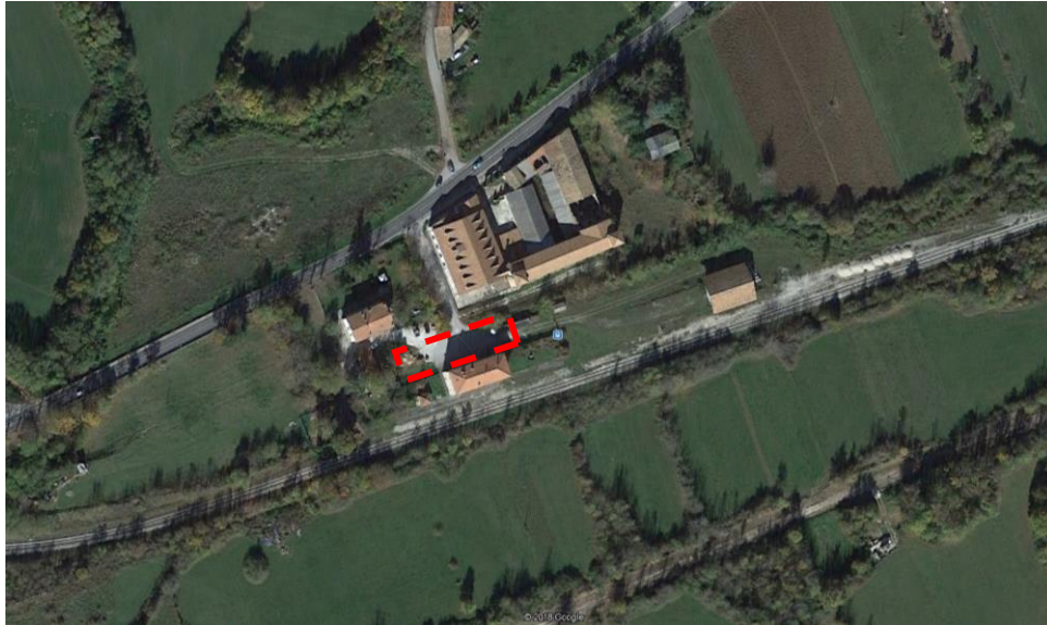
Stazione ferroviaria di Alfedena
