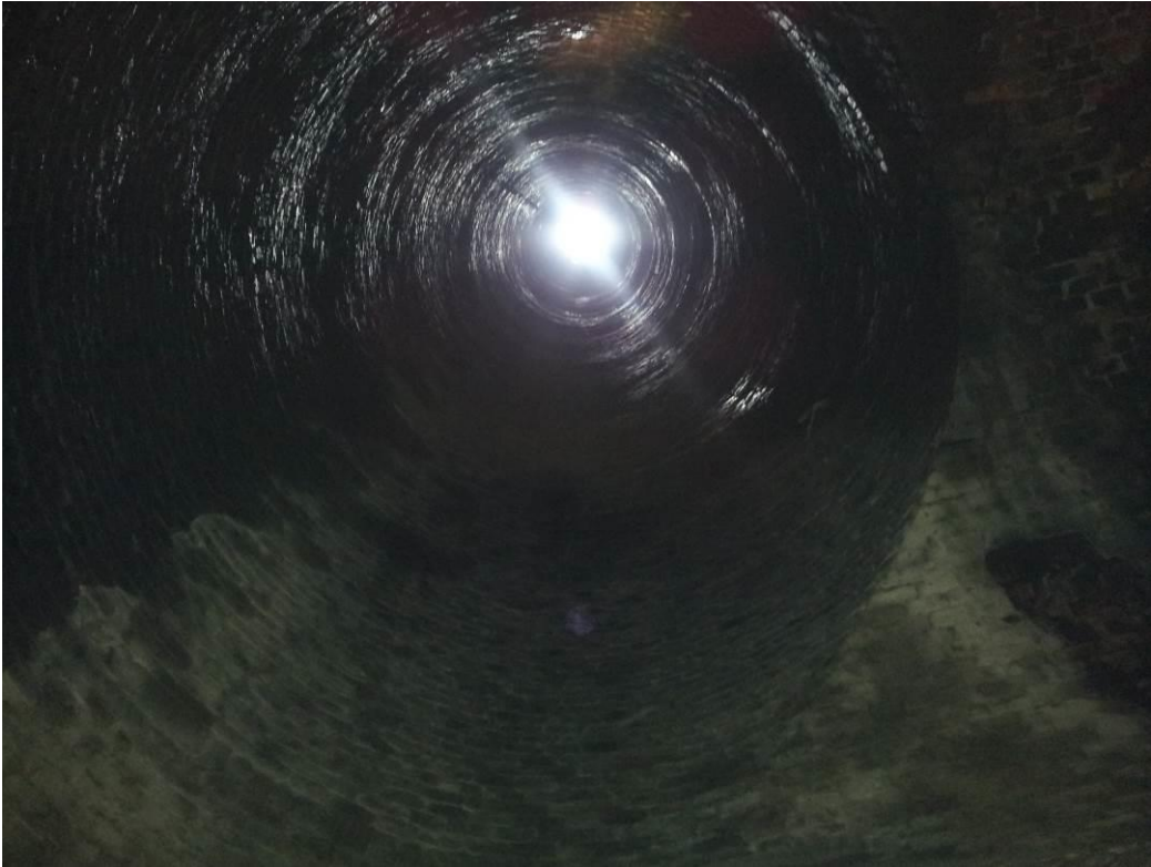
Vista interna del pozzo al km 84+620 ( lunghezza 103m )
