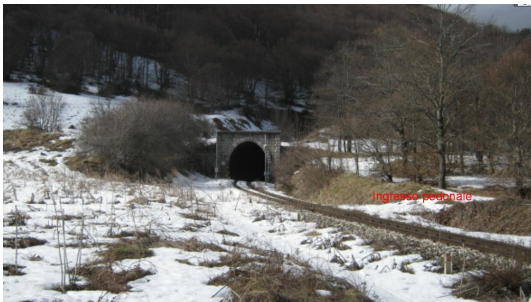
FOTOGRAFIA IMBOCCO LATO CARPINONE
