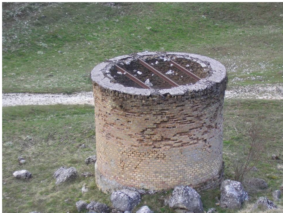
Vista esterna del pozzo al km 40+090 (lunghezza 126m)
