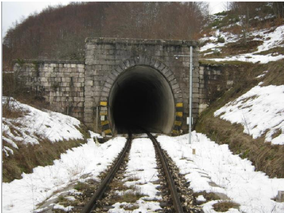
FOTOGRAFIA IMBOCCO LATO SULMONA
