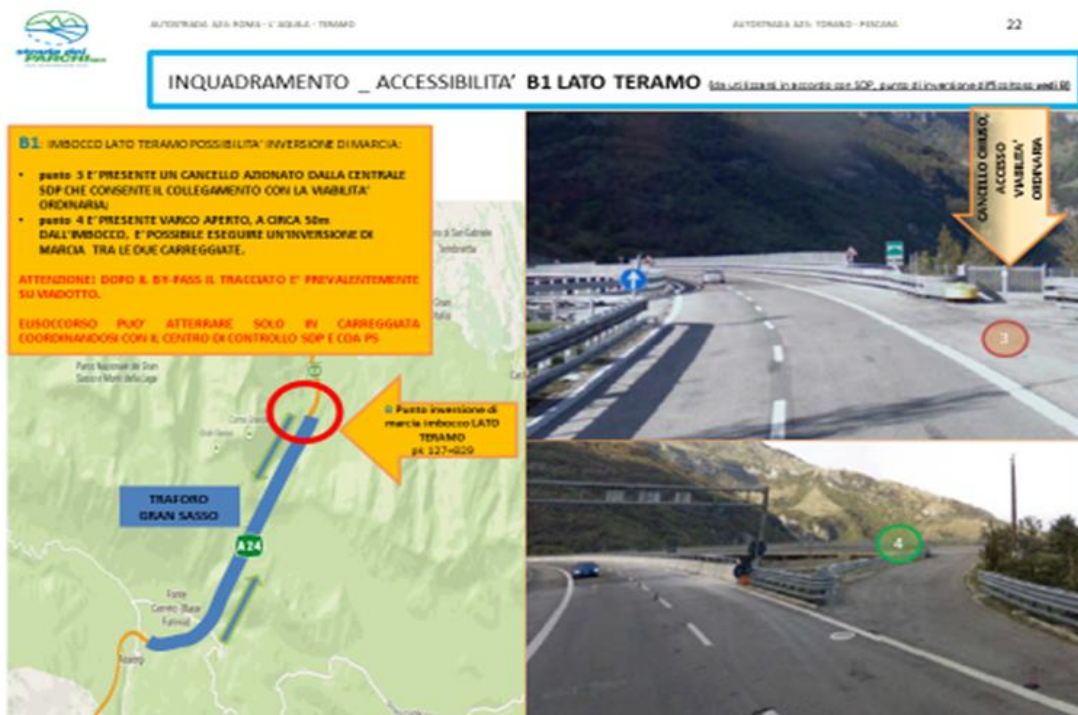
Figura 24 – Accessibilità lato Teramo – in corso di ultimazione
