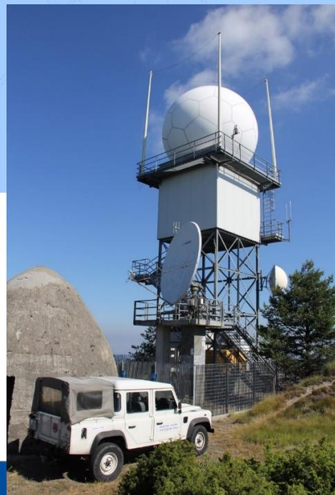
Il radar meteorologico di Monte Settepani, di proprietà congiunta delle regioni Liguria e Piemonte, è un radar GPM250C, in banda C, doppler, polarimetrico. E' installato alla quota di circa 1400 metri s.l.m (latitudine 44.247, longitudine 8.199). Il sistema di trasmissione e ricezione dei dati in tempo reale è di tipo a ponte radio.
