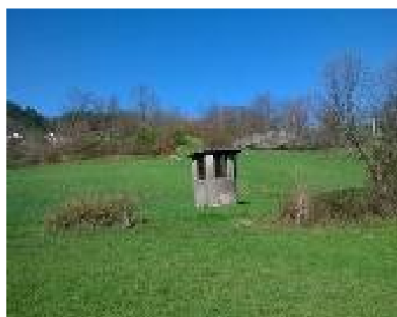
Il camino/pozzo di aereazione visto dall’esterno, in loc. S. Michele nel comune di Piazza al Serchio
