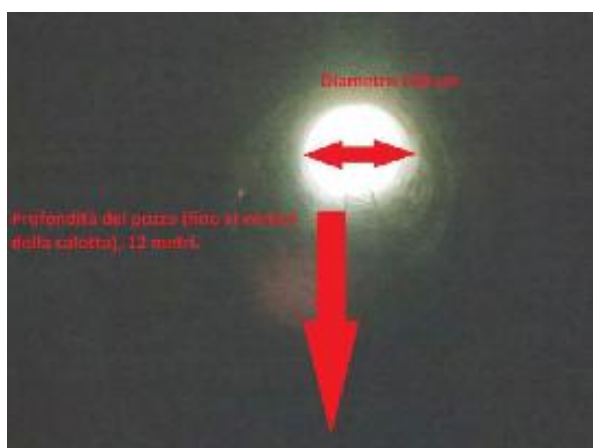
Il camino/pozzo di aereazione visto dall’interno della galleria
