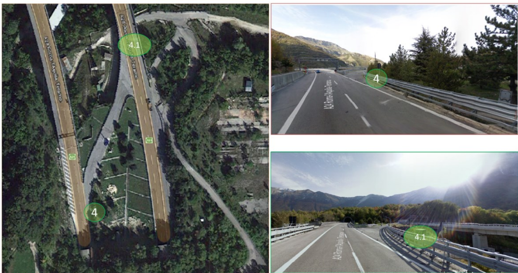
Figura 33 – Varco esterno lato Teramo (omissis).
