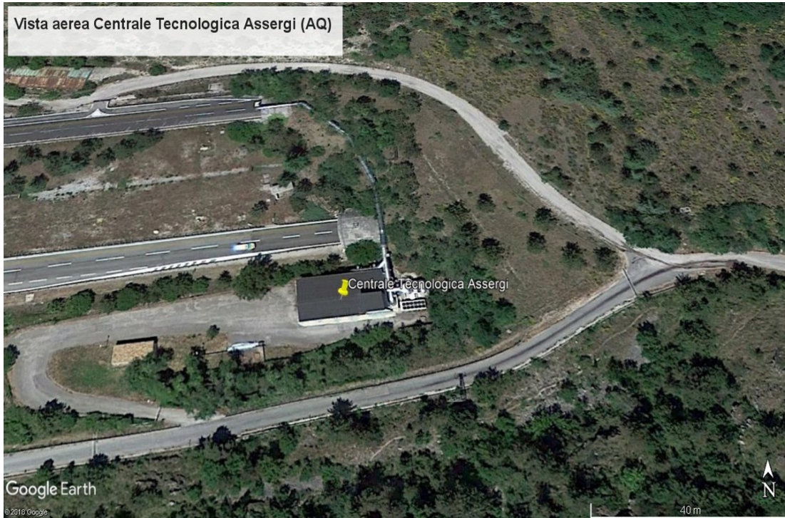
Figura 3 – Vista satellitare Centrale Tecnologica Assergi (AQ) (omissis)
