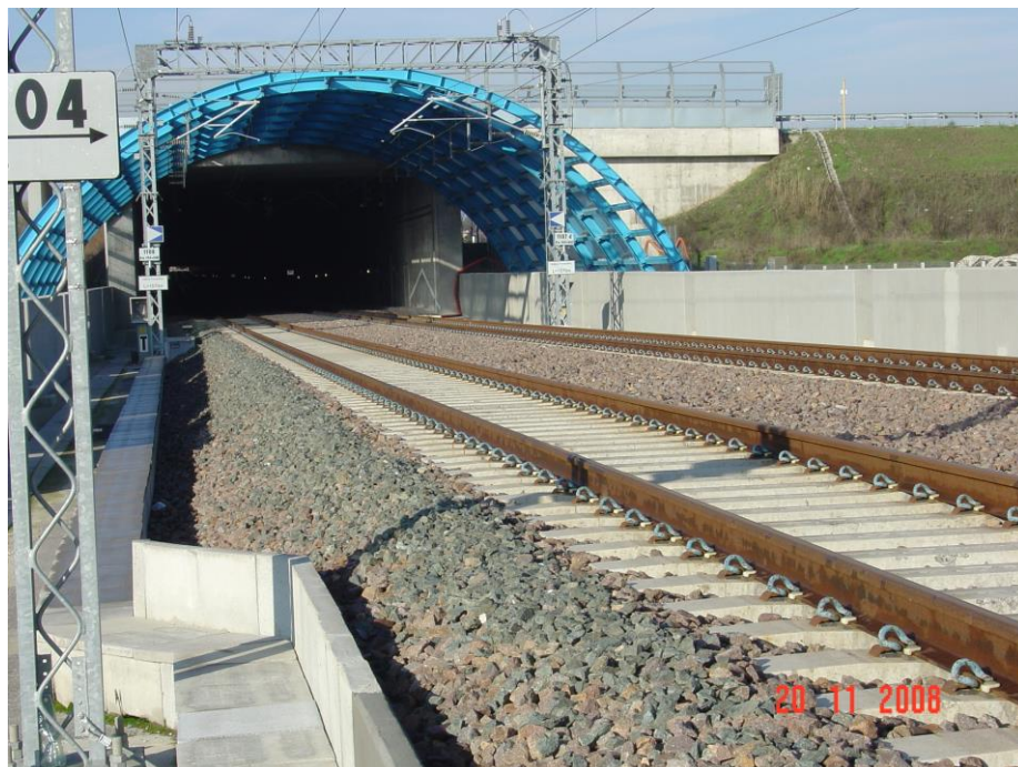
Vista dell'ingresso della galleria lato Bologna.
