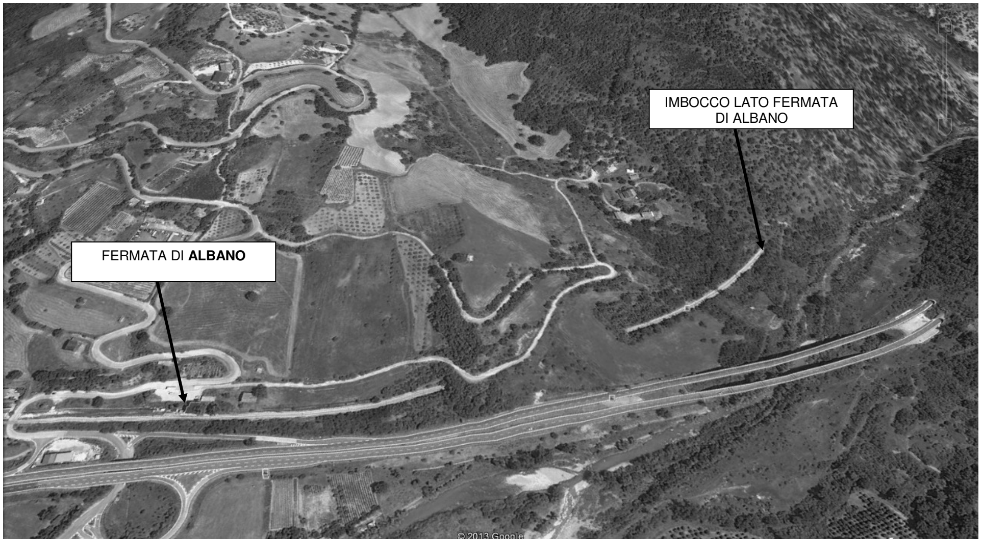
Figura II : IMBOCCO LATO ALBANO
