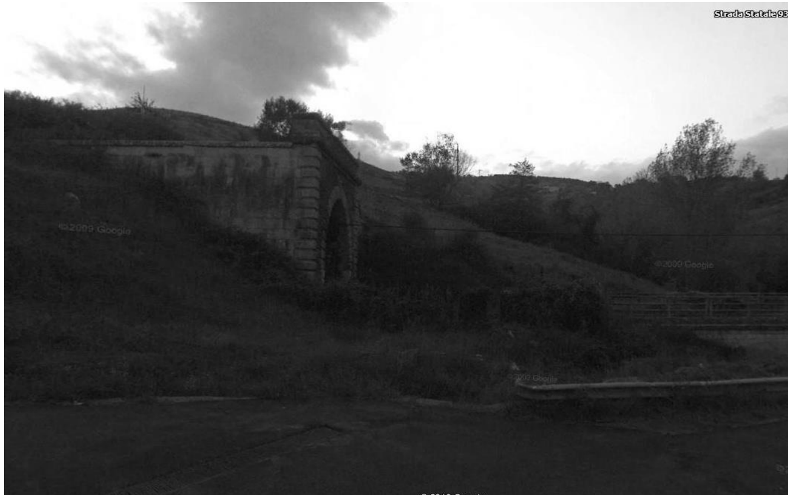
Figura III-9 : IMBOCCO LATO STAZIONE PIETRAGALLA SCALO (Comune di Avigliano- Fraz. Giardiniera)
